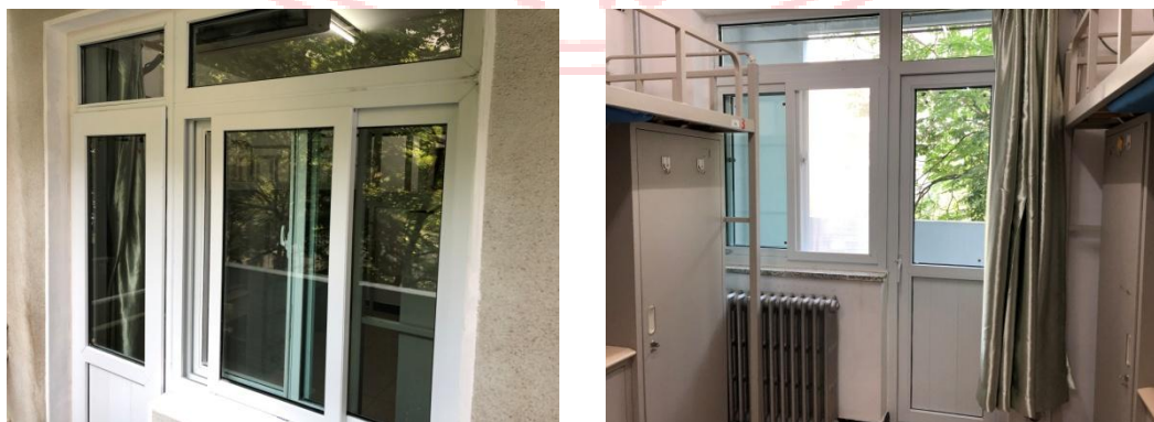
△塑钢窗更换完毕
