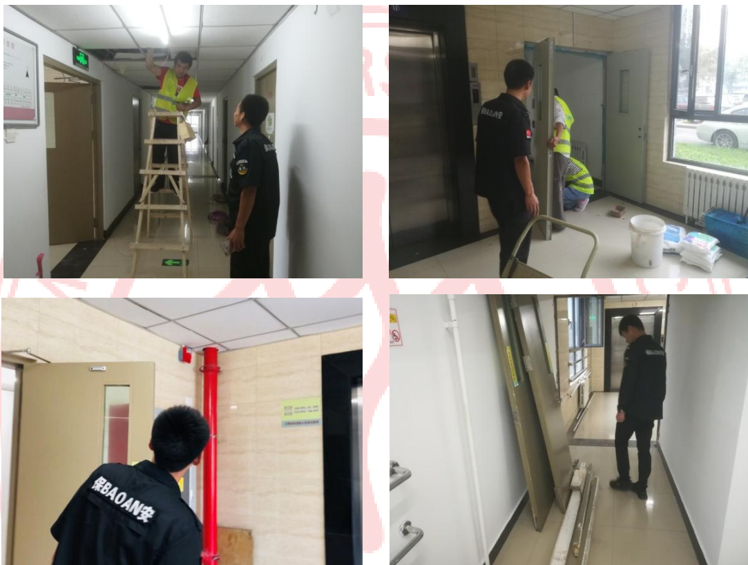
△巡查施工情况
