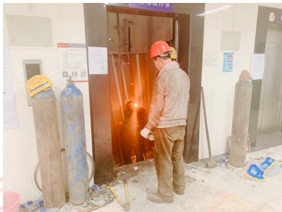
△检查电梯工程施工情况
