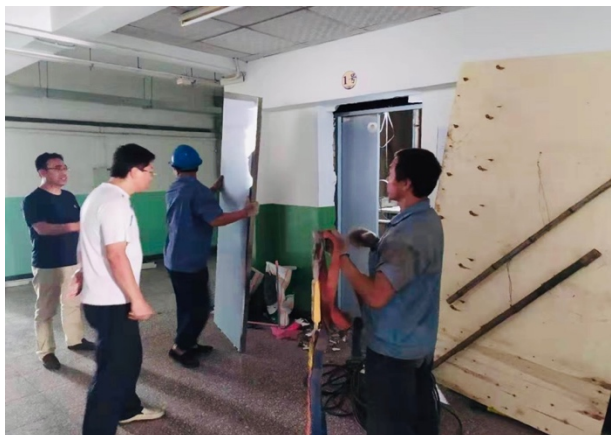
△检查施工“动火证”
