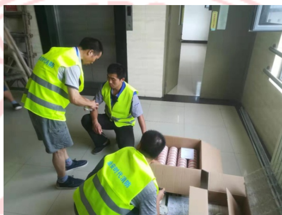
△消防报警系统改造现场
