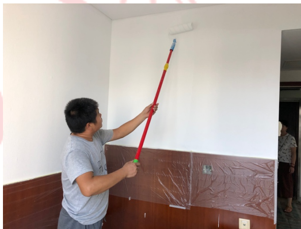
△现场施工情况
